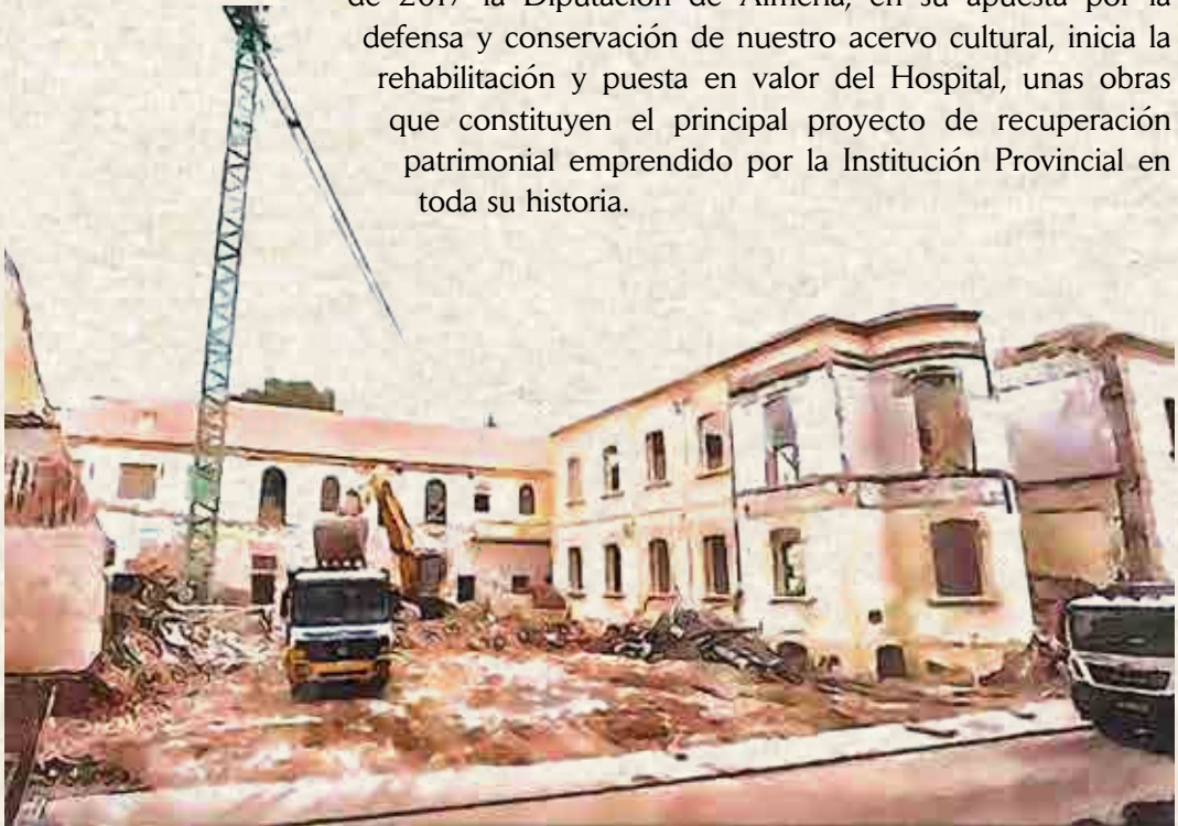
Demolición del Hospital Infantil
