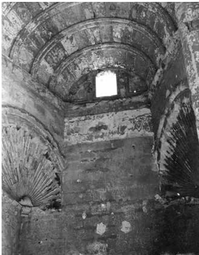
Trompas aveneradas del cruceiro de la iglesia de Santo Domingo de Almería
