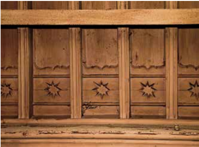
Chellas y alfardones de la armadura
