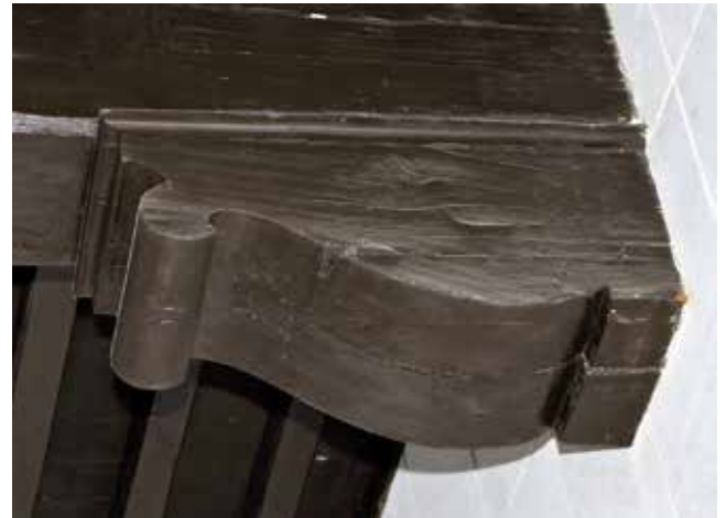
Ménsula de la armadura de la biblioteca
