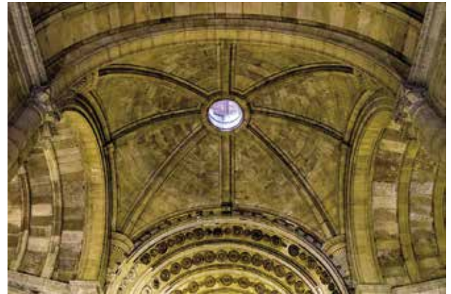
Bóveda del crucero
