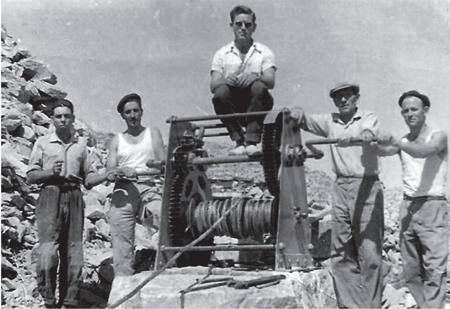
Canteros con cabestrante. Máquina usada para el arrastre de bloques, facilita la labor en la cantera utilizando un hilo acerado atado a un gancho forjado, se mueve mediante manivelas y engranajes. Fotografía: Macael Antigua
