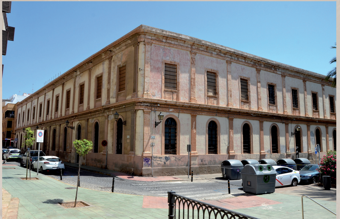
Fachada exterior a poniente.
