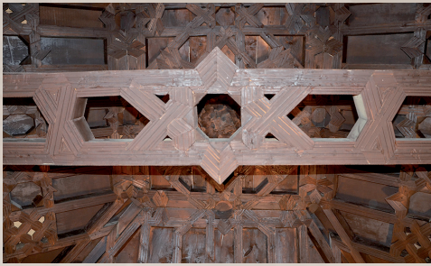
Detalle de un tirante de la misma armadura.
