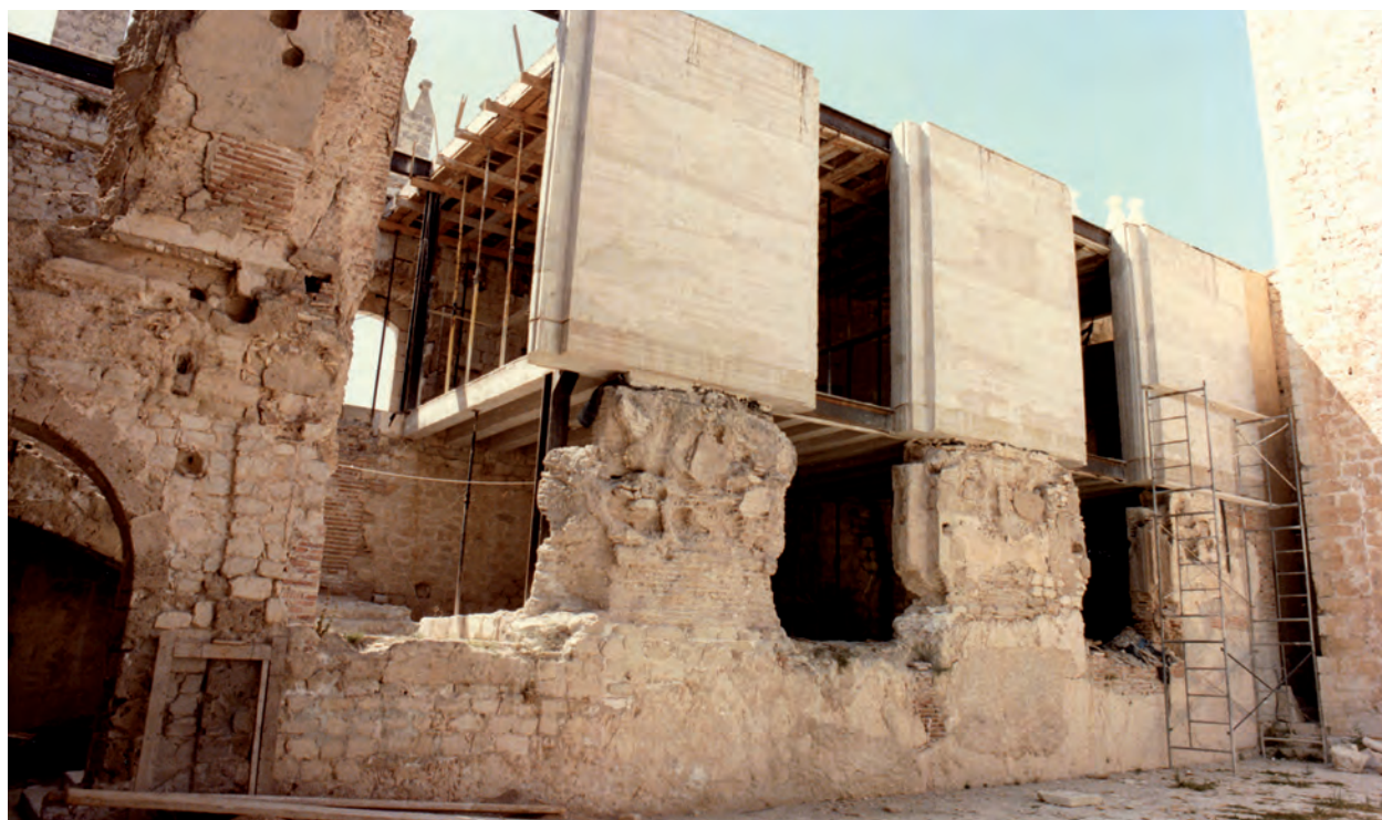
Recuperación del volumen original del patio con la reconstrucción de las estancias del cuerpo de ventanas. Intervención dirigida por Juan Antonio Molina y Juan Antonio Sánchez.
