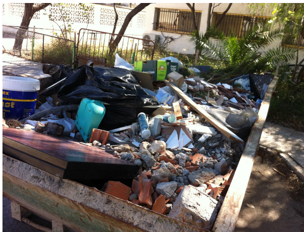
Imagen de almacenamiento no controlado de residuos especiales y peligrosos
